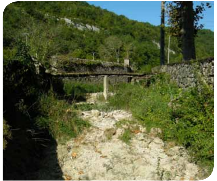
Le ruisseau de la Sagne asséché en amont du bourg de Cabrerets
